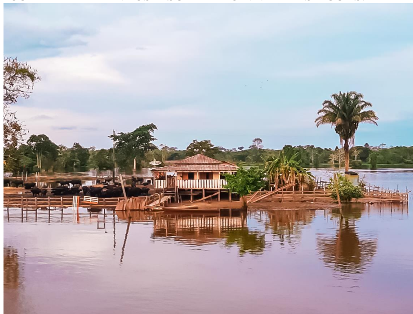
FIGURA 5 - PALAFITA E MAROMBA, ESTRATÉGIAS DE ADAPTAÇÃO DA RESIDÊNCIA E CURRAL RIBEIRINHOS À SUBIDA DO NÍVEL DAS ÁGUAS.
