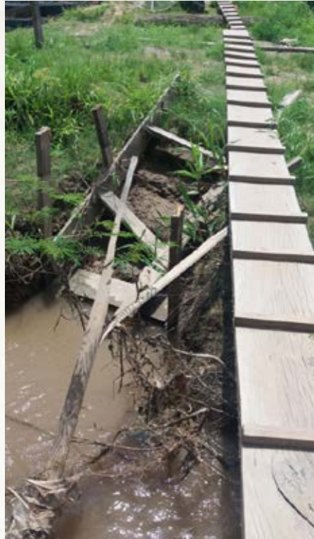
Figura 36 - Ilustração da ponte recém-instalada para acesso às embarcações
